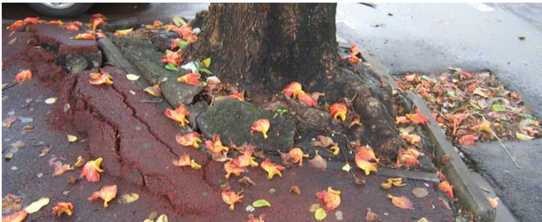
Figura 5.1.1 | Superfície da calçada danificada por raiz de árvore
